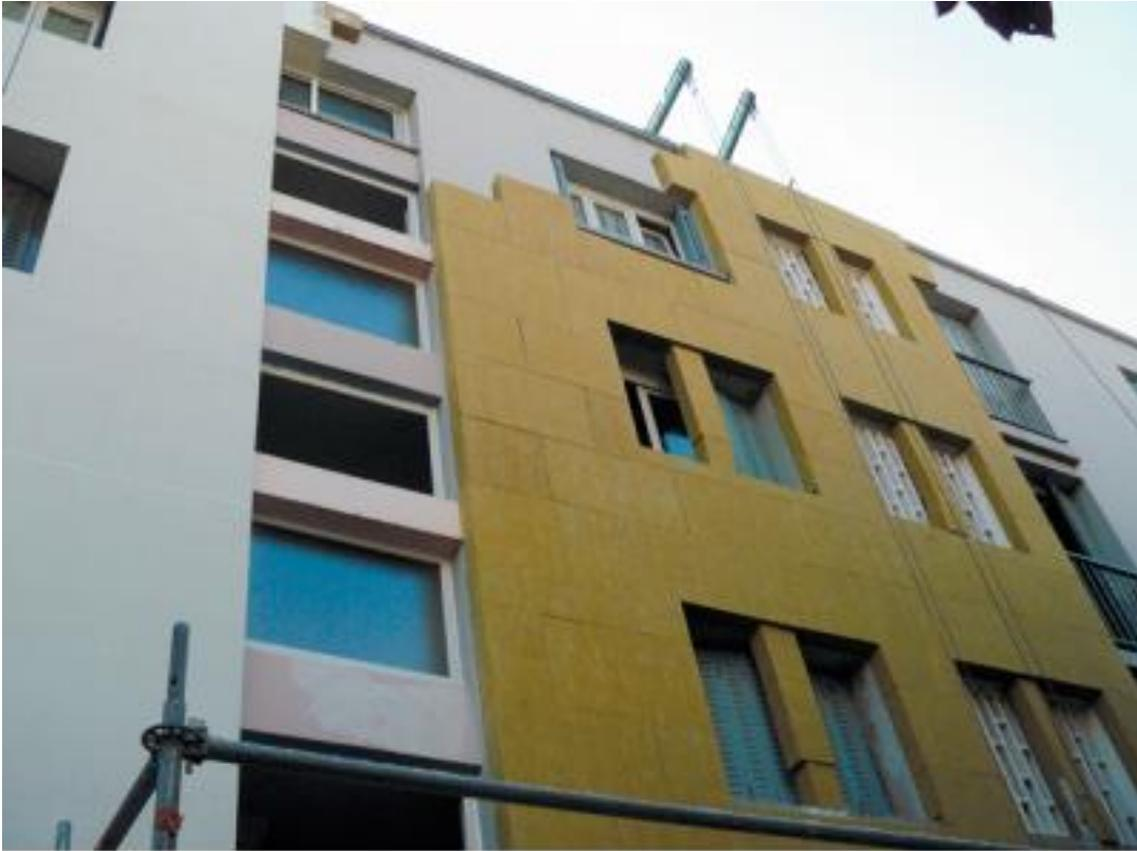
Figura. Colocación de SATE sobre fachada existente
