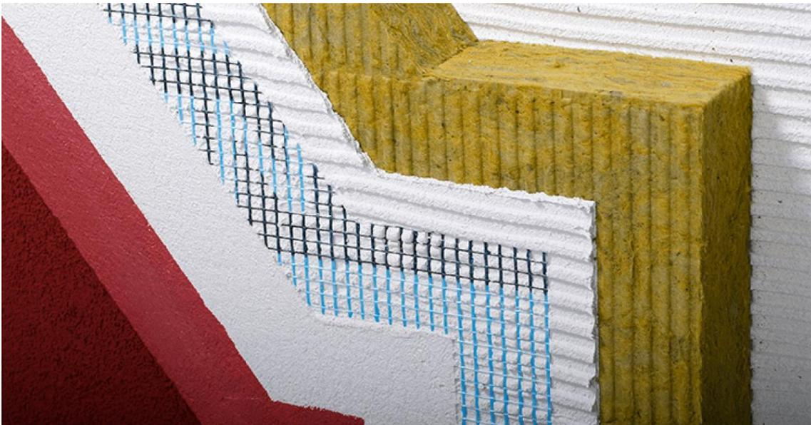
Figura: Composición de cada una de las capas del SATE, incluida la terminación final. Su apariencia es la de una fachada monocapa
